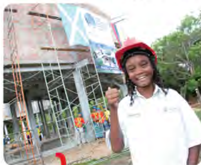
Actualmente se construyen estaciones terminales del cable submarino en San Andrés Isla y en San Felipe de Tolu, Sucre.
